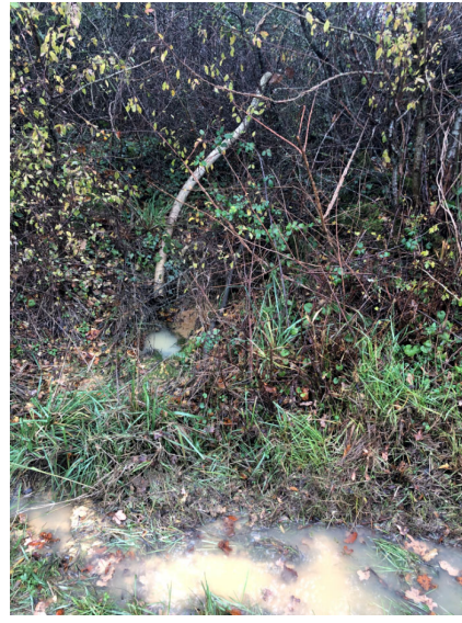
Exutoire du site (tuyau)
